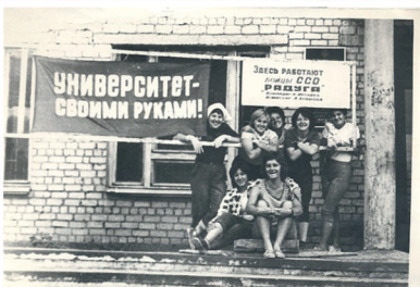
Бойцы стройотряда «Радуга» на строительстве корпуса университета. Командир Н. Юртаева, комиссар Храмова. 1977 г.
