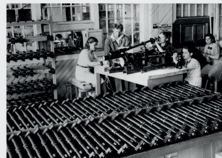
Сборка артиллерийских стереотруб на заводе № 297 г. Йошкар-Олы. 1943 г.
